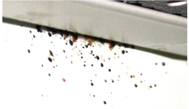
Chinches en falso techo
