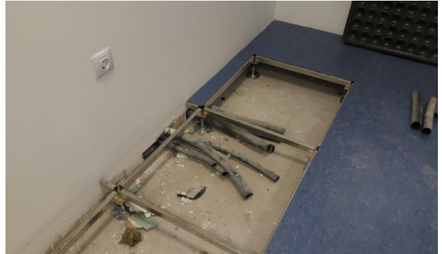
Pavimento elevado registrable con pasatubos
