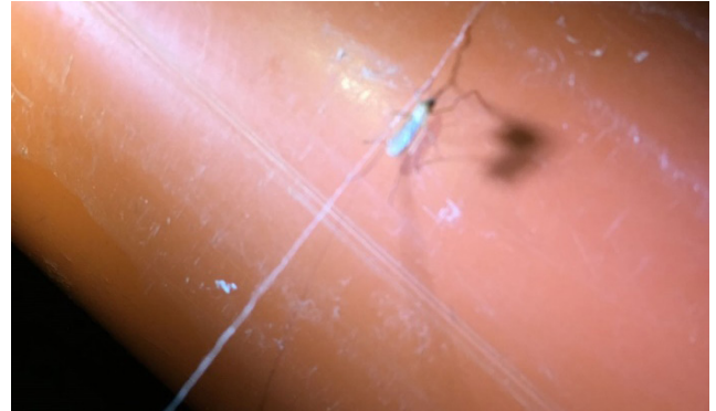
Ejemplar de mosquito sobre colector bajante en cámara de aire
