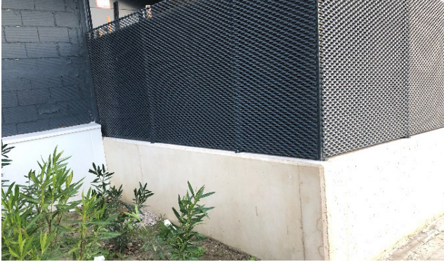
Vallado perimetral de alta protección contra plagas
