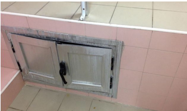
Trampilla de acceso a suelo técnico: cierre no hermético
