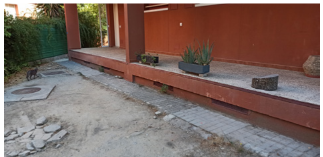
Cámaras sanitarias en soportal
