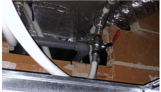
Falso techo comunicado con paso de conducciones
